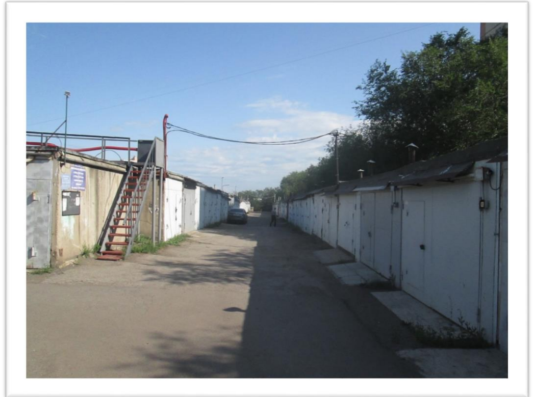
г. Магнитогорск, ГК «Строитель-За», в районе ЖК «Ладья»
